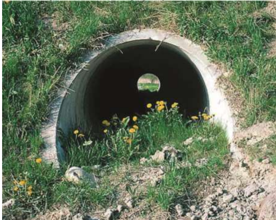
Foto 118 Näide väiksemõõtmelisest läbipääsu truubist tee all (laius ca 1m), mis tagab pisiimetajate läbipääsu. Truubi põhi on täidetud pinnasega. Foto allikas: https://handbookwildlifetraffic.info/
