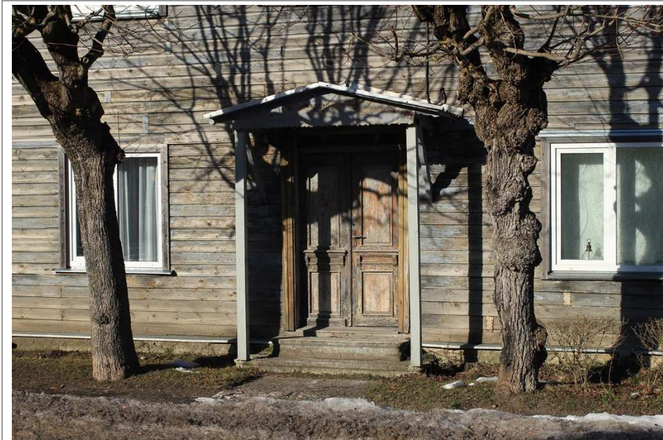
Foto 67. Hoone Tallinna mnt. 15. Tähelepanu väärivad rohked originaaldetailid, sh. paekivist sissepääsu kõnnitee, välistrepp, välisuks ja varikatuse karniis. Varikatuse konsoolid ja tugisambad on taastatud originaaltruult. Foto: Maarja Tüür, 2019
